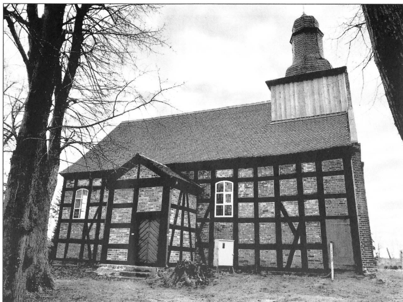
DIE SANIERTE DORFKIRCHE in Landin
